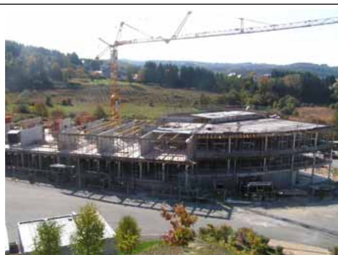
Octobre 2005 : 1 er et 2 nd étage en construction
