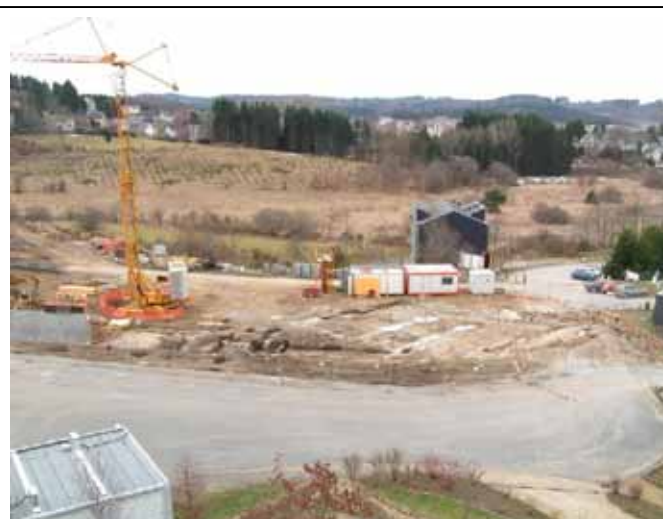
Mars 2005 : les fondations sont coulées
