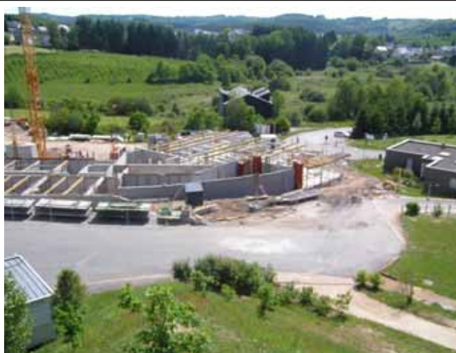
Juin 2005 : le rez de chaussée est mis à jour
