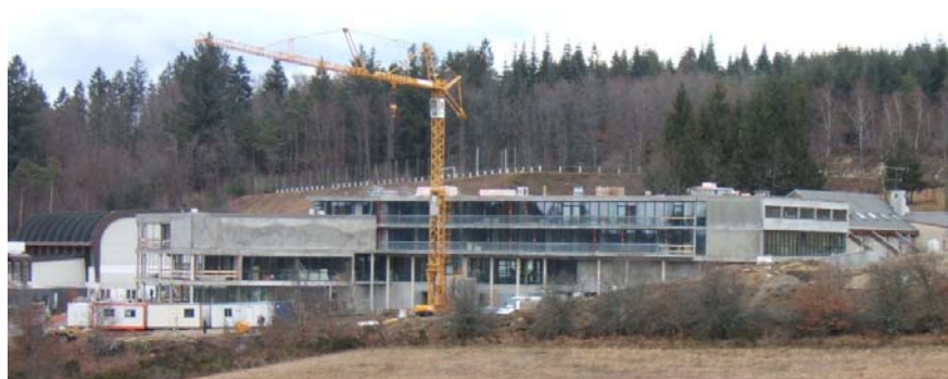
Les travaux extérieurs laissent place à l'aménagement intérieur. Crédit Photo O.CONTRAN
